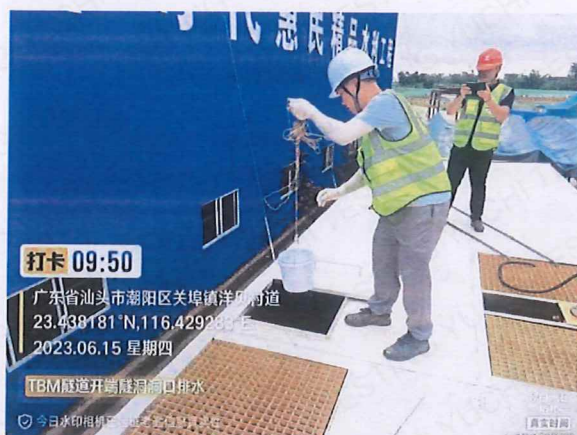
TBM 开端隧洞排水
