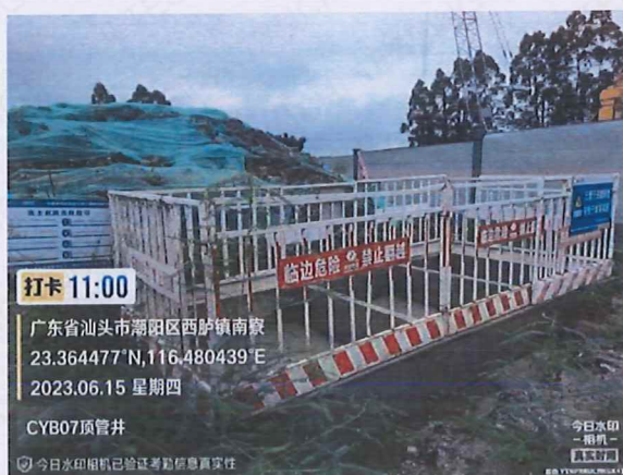
CYB07 顶管井生产废水
